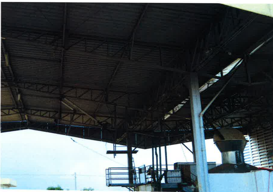
Vista da Calha Central
