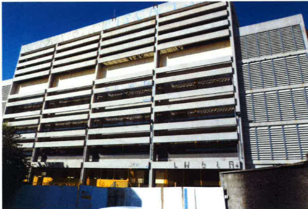
Vista da fachada frontal da escola
