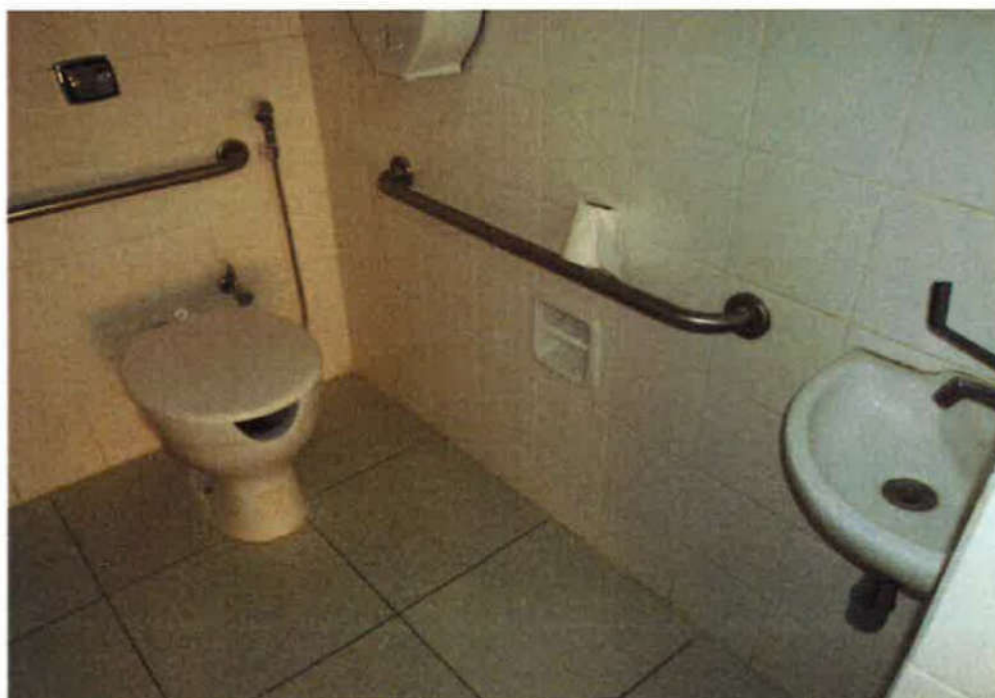
Sanitário com acessibilidade
